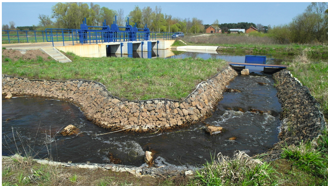
Nowoczesna przeplawka umożliwiająca migrację ryb przy nowym jazie na Łasicy niedaleko ujścia Łasicy do Bzury
