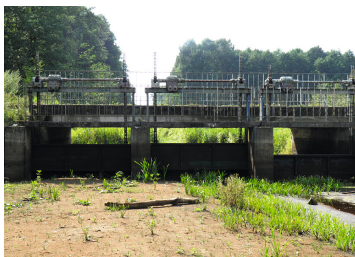
Odpowiednio wcześnie zamykanie jazów to jedyna metoda by w lecie nie zabrakło wody w kanałach – na zdjęciu jaz na Łasicy w Nowej Dąbrowie w okresie suszy
