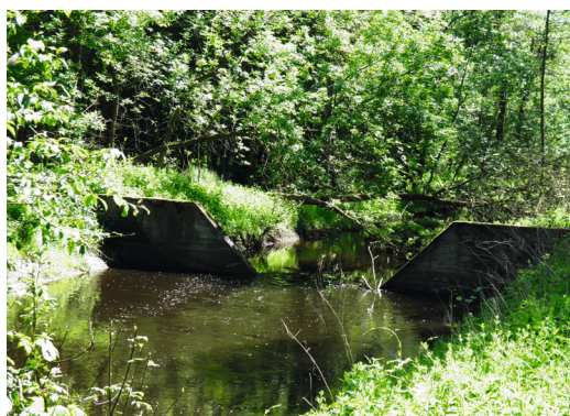
Stały próg piętrzący wody Kanału Zaborowskiego powyżej ujścia do Łasicy w OOS Żurawiove. Ma on duże znaczenie dla właściwego uwodnienia występujących tam cennych siedlisk mokradłowych
